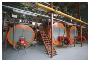
ボイラー廃熱
